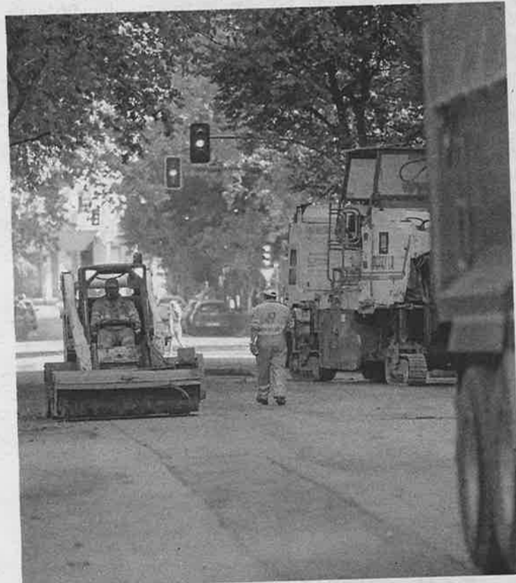
Máquinas trabajando ayer en la avenida de España. JORGE REY
