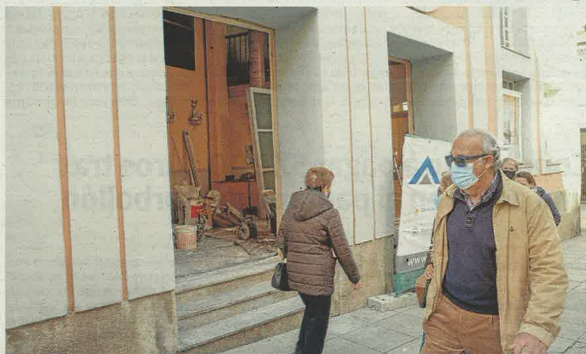
Imagen de las entradas al Gran Teatro mientras se instalaban las puertas nuevas esta semana pasada. A. MÉNDEZ
