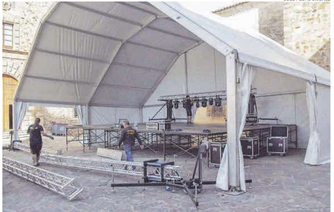
Operarios instalan el escenario del Irish Fleadh, este jueves.
